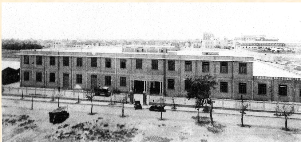
1925 Εργοστάσιο σιγαρέτων Παπαθεολόγου
